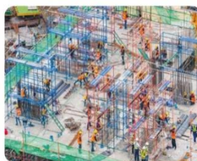
GENERALNE WYKONAWSTWO W ZAKRESIE BUDOWY I FIT-OUT
